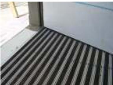
Alfombra fabricada con hilo de PVC entrelazado. La arena y la suciedad es arrastrada de los zapatos por medio de los filamentos y cae a través de la alfombra hasta la superficie inferior. Diseñada para aplicaciones en exterior e interior, debido a su espesor de 15-16 mm permite su instalación en cajeados en el suelo, además de la posibilidad para unir piezas e instalarle bordes perimetrales (rampas).
